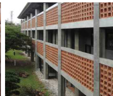
榎ブロック(穴あきブロック)の手すり
