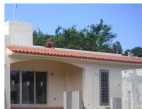
断熱瓦葺きの屋根
