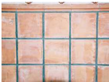
タイルを貼った壁面
