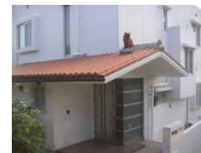
断熱瓦葺きの庇
