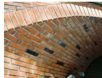
レンガを使用したアーチ壁
