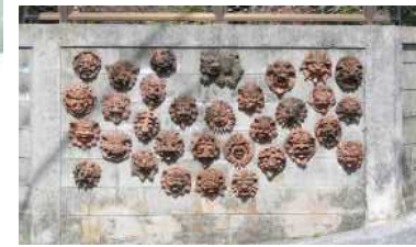
壁掛け面シーサー
