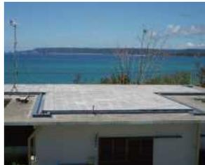
コンクリート製の遮熱平板を敷いた屋根
