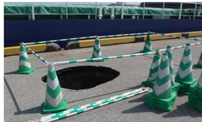
【新港地区の岸壁エプロンの陥没】
