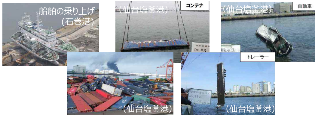
コンテナターミナルの岸壁、荷役機械損傷、コンテナ流出、様々な漂流物
