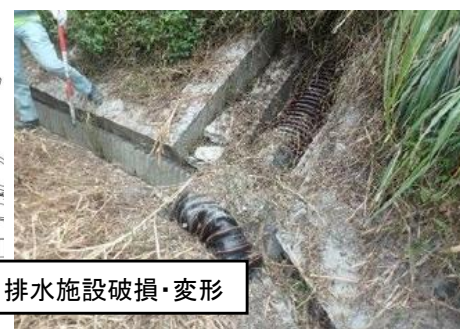
法枠内土砂の吸出し
