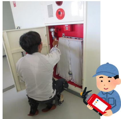
屋内消火栓設備ホース外観点検
