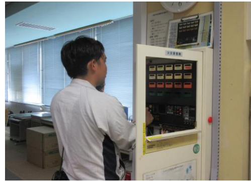
非常ベルの鳴動試験
