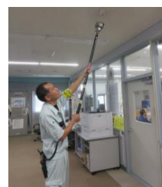
自動火災報知設備の 火災感知器作動試験
