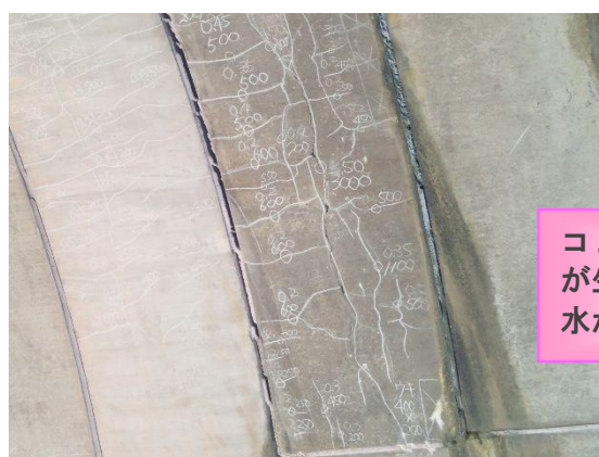
写真-1 早急な補修が必要となる例
