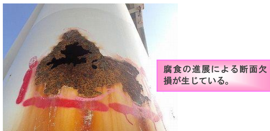
写真-1 早急な補修が必要となる例
