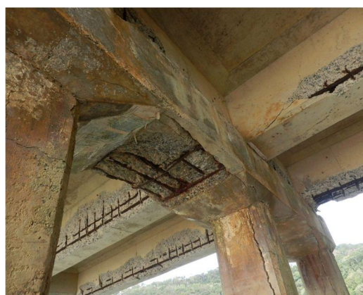
写真-1 早急な補修または架替の検討が必要となる例
