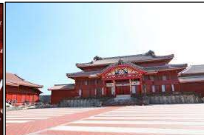
正殿外 (火災・避難状況確認)
