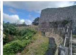
城壁外東階段エリア
