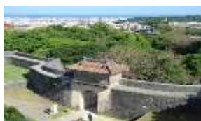
城郭内 (消防隊進入確認)
