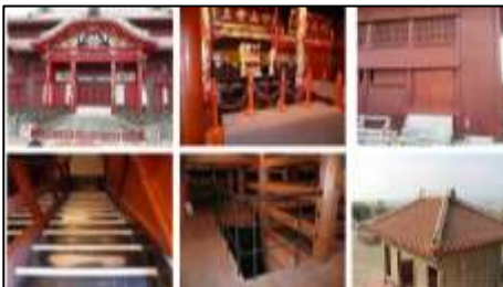
正殿内外 (火災・避難状況確認)
