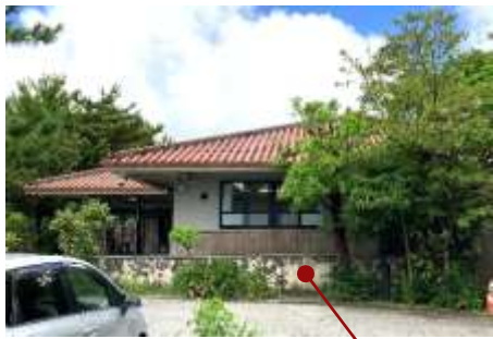
既存施設：北側面現況
