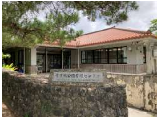
現況写真(既存)
