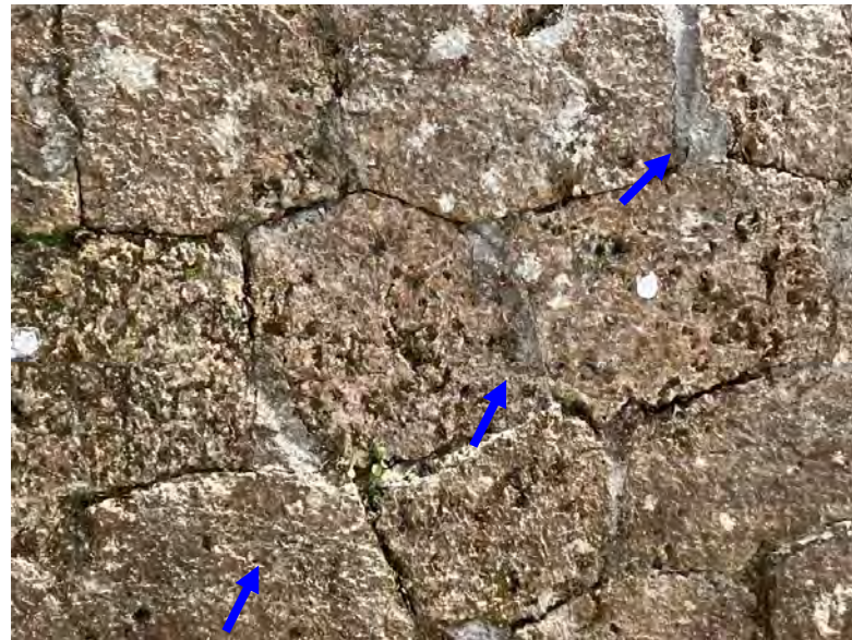
モルタル補修箇所の状況写真
