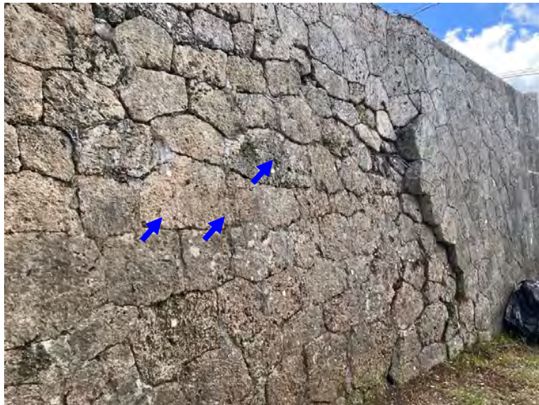
モルタル補修箇所の状況写真
