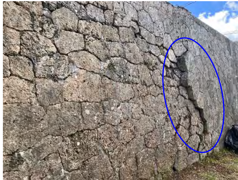
県道側、既設石積との段違い状況写真
