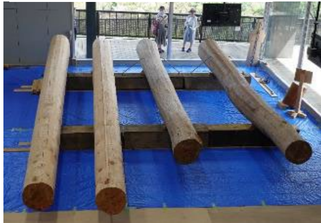
■原寸場【小屋丸太梁材の製材・展示状況】
