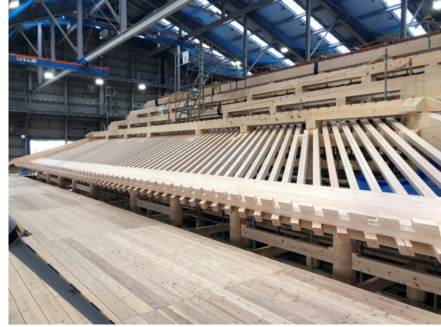
■素屋根見学エリア3階フロア【上層軒廻りの建込み(化粧垂木、木負)】
