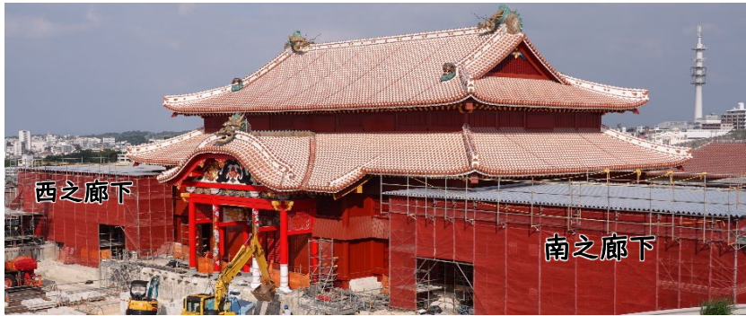
正殿外観 (R8.1撮影)
