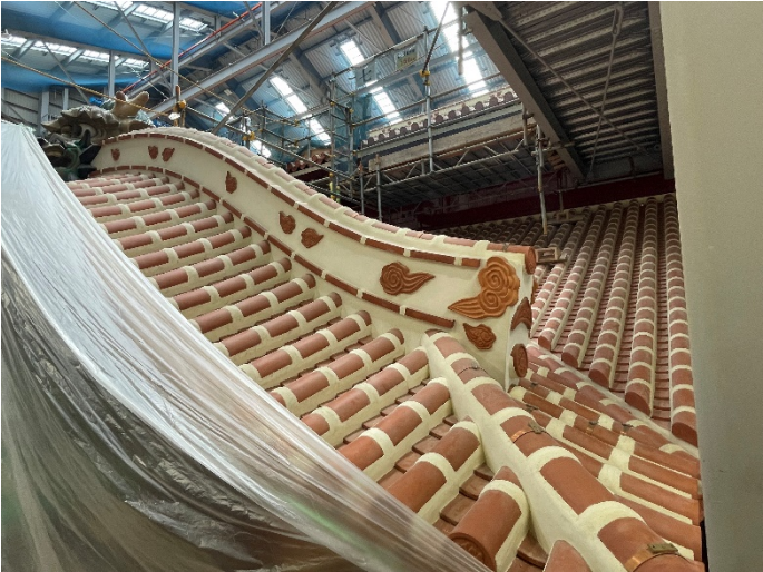
雲形飾瓦施工状況(2025. 6. 24撮影)
