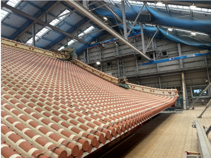
上層施工状況(2025. 6. 24撮影)
