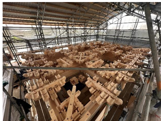
三門本体一階上層・斗拱Aタイプ設置完了
