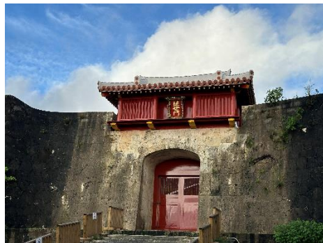
継世門櫓修復工事完了
