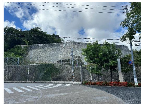
南城郭石積み解体・積み直し工事完了
