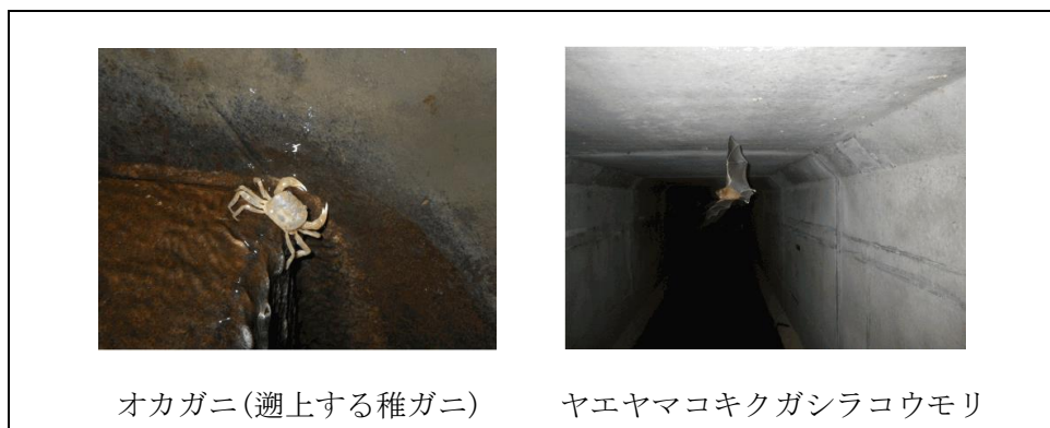
図 2.23 場外排水ボックスカルバート内の通過利用状況
