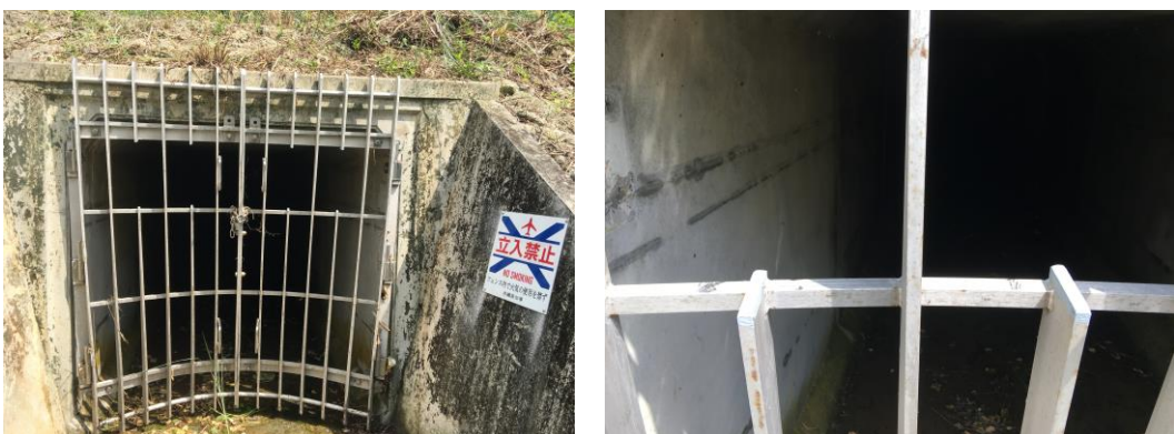
図 5.27 (3) ボックスカルバート西側出入口 (撮影：平成 29 年 4 月 10 日格子間引き)
