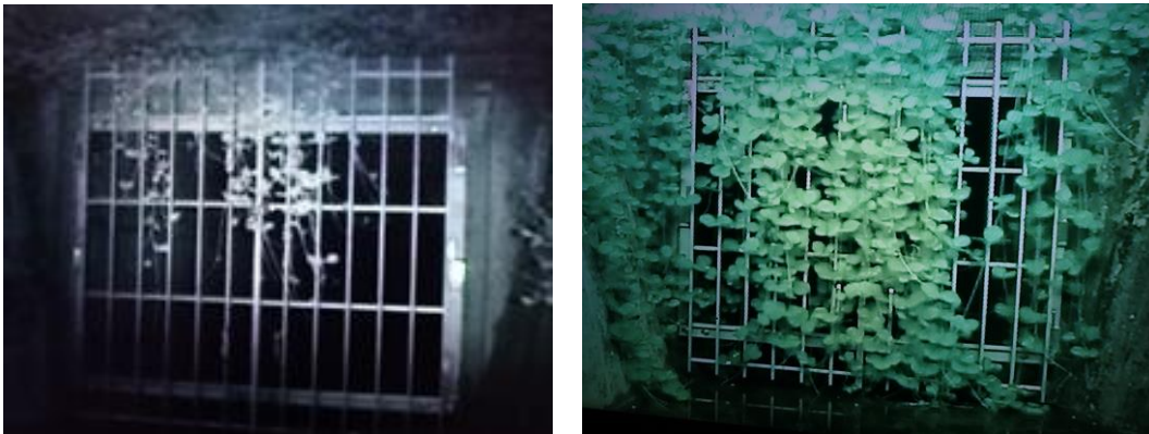
図 5.27 (2) ボックスカルバート西側出入口 (撮影：平成 28 年 5 月(右)、6 月(左))
