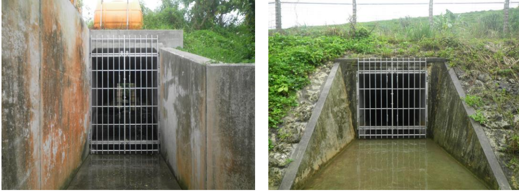
図 5.27 (1) ボックスカルバート出入口 (平成 28 年 3 月 22 日設置)
