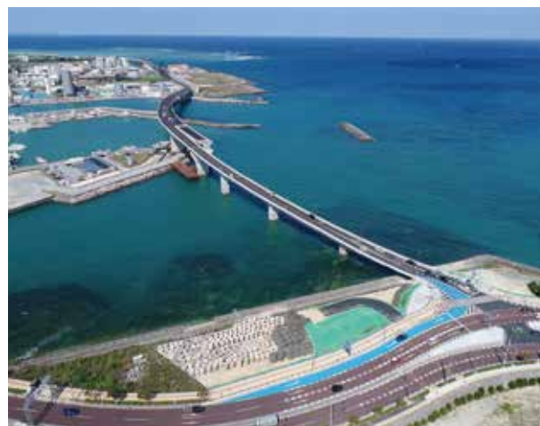
国道 58 号 浦添北道路
