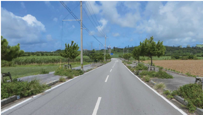
(写真箇所：城辺長間～下里添区間)
