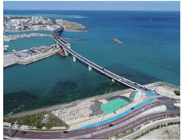
国道 58 号 浦添北道路
