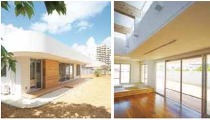
敷地は都市部の住宅街にあり、進入路が狭く、高低差のある敷地に計画された4人家族のためのZEH住宅です。構造は鉄筋コンクリートと木造による混構造の平屋です。南側にリビング・ダイニングと和室を配置し回遊性のある平面計画としなが
