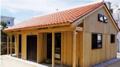
敷地は地方都市の伝統集落地区の景観指定を受けた地域に計画された3人家族のための気候風土適応住宅です。木造の在来工法を採用し、赤瓦屋根や石垣の塀など集落の景観になじむように計画されました。南側にリビング・ダイニングを配置し、
