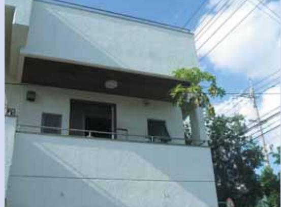
グループホーム外観（民間住宅を活用）
