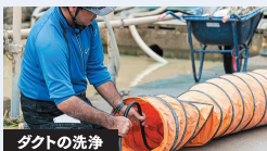
ダクトの洗浄
