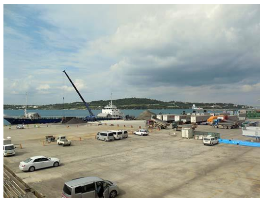
④港内は資材の搬入等で活用
