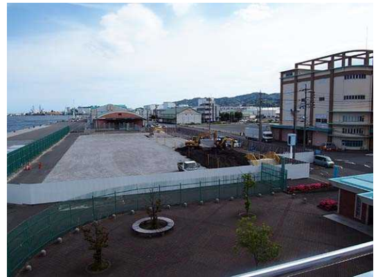
5号上屋が撤去され、緑地を整備
