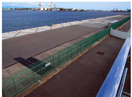
岸壁の周囲を囲む SOLAS 条約対応のフェンス
