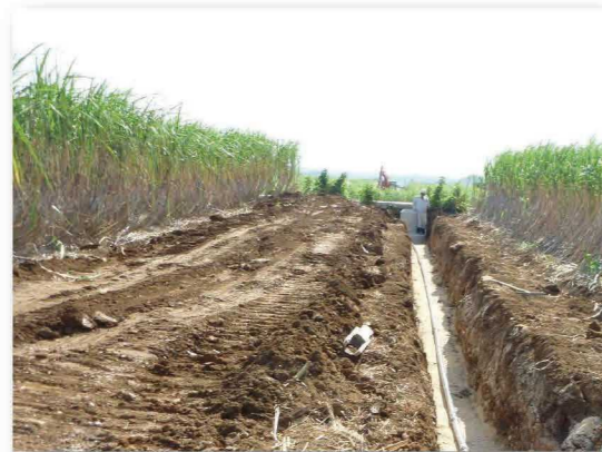
管路の布設作業
