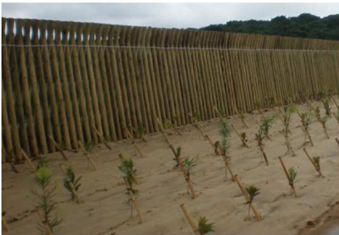
農地保全整備事業（防風施設）
