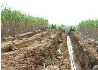
管路の布設作業
