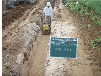
②管基礎材均し転圧
