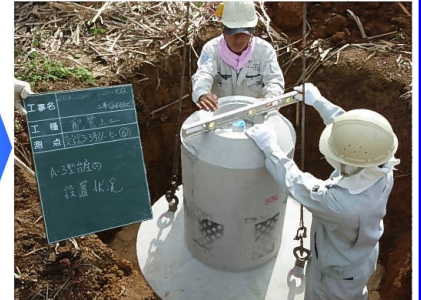
③台座設置
