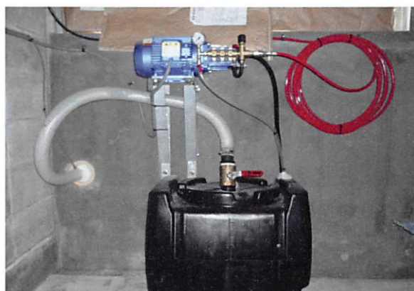
図4 動力噴霧器と殺菌水タンク
