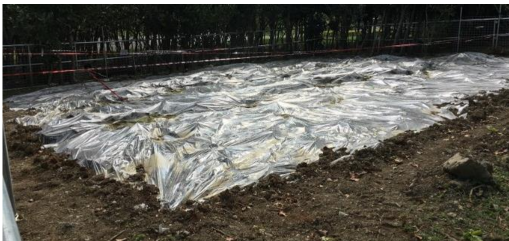
図 5-5. ガスバリアー性フィルムで被覆した状況 写真の事例では鳥類による被覆の損傷を防止するため防鳥テープを設置
