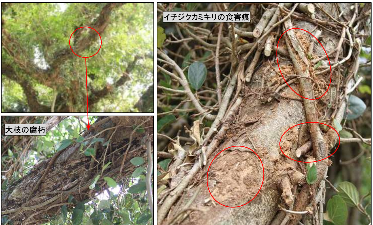
大枝折れの可能性が高く明らかに危険、中・小枝落下の可能性高い 認定番号 61 ノロ殿内のガジュマル
