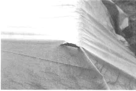
緊迫面での破損
