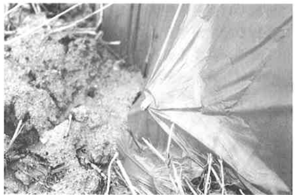
枝による破損
