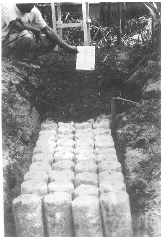
写真-5 堆肥区の埋め込み状況
