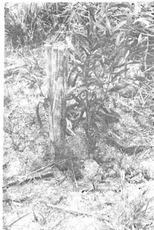
写真-1 杭打工法
