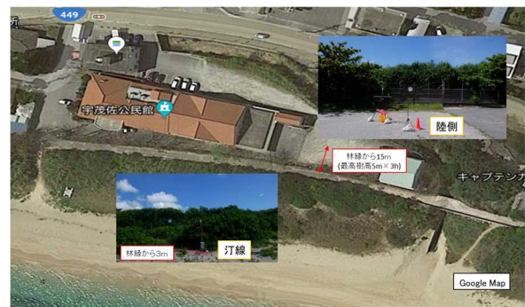
図-11 宇茂佐の調査機器設置状況
