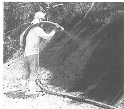
写真-1 吹付状況
