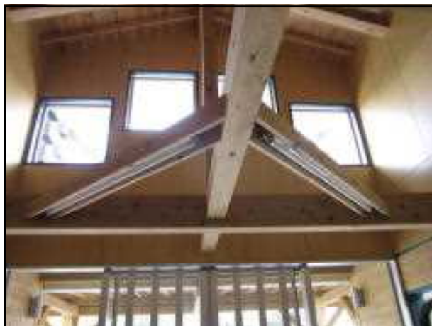
玄関ホールの壁材（イジユ突板）
