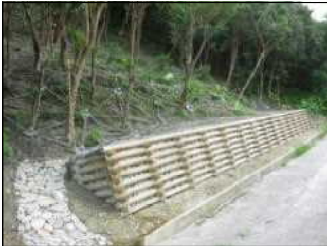
山腹崩壊防止対策の状況 (南城市)
