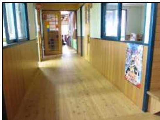
イジユの突板を利用した腰壁（東村）
