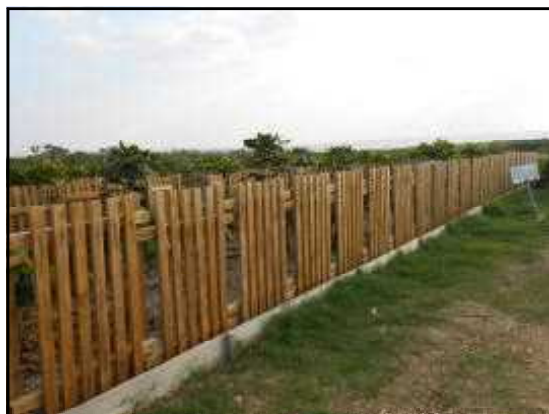
木製パネル防風工（糸満市）
