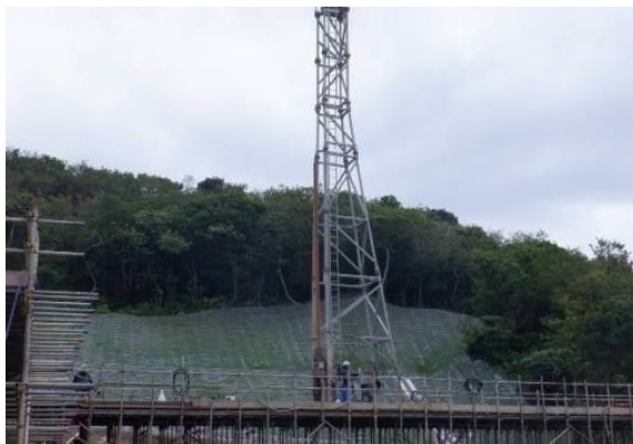
復旧治山（中城村奥間）
