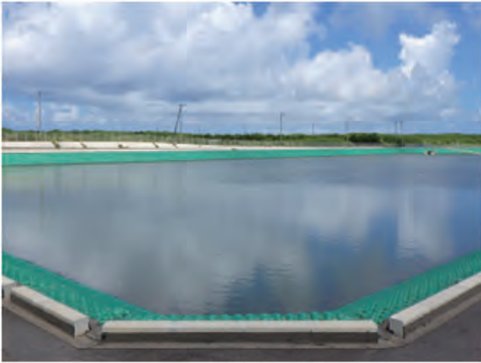
水利施設整備事業 津堅地区
