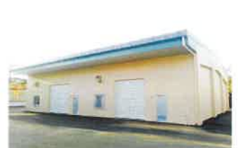
集出荷施設の整備
