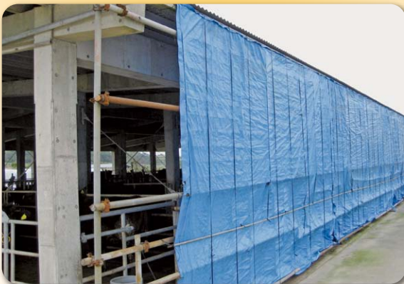
写真1. 風上側全体にシートによる防風対策
