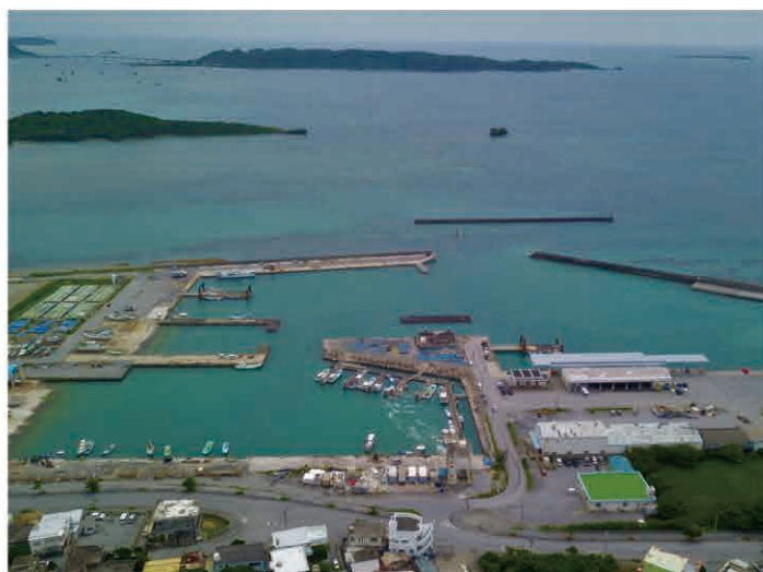
水産物供給基盤機能保全事業 平敷屋漁港
