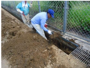
排水路の土砂上げ
