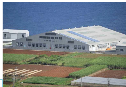
農村集落基盤・再編整備事業 (地域資源利活用施設整備)
