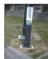
避難標識の設置
