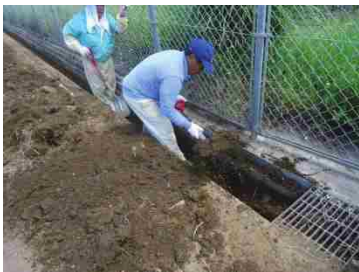
排水路の土砂上げ
