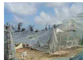
園芸施設の被害
