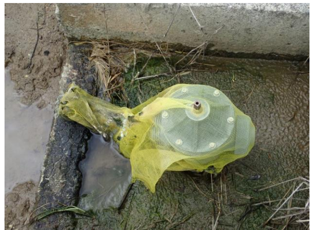
図6 取水口の侵入防止網
